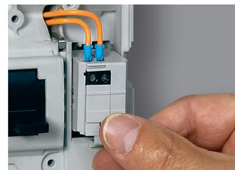
Los auxiliares se instalan en ranuras específicas debajo del panel frontal.
