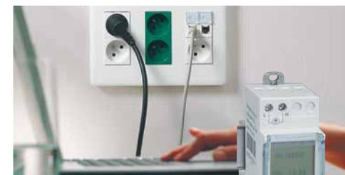
Las bases de corriente, combinadas con un interruptor horario programable, permiten llevar a cabo una desconexión automática del suministro eléctrico de equipos de oficina como, por ejemplo, impresoras o fotocopiadoras durante la noche o los fines de semana.
