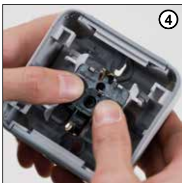
Cablea el mecanismo y presiona para fijarlo a la caja
