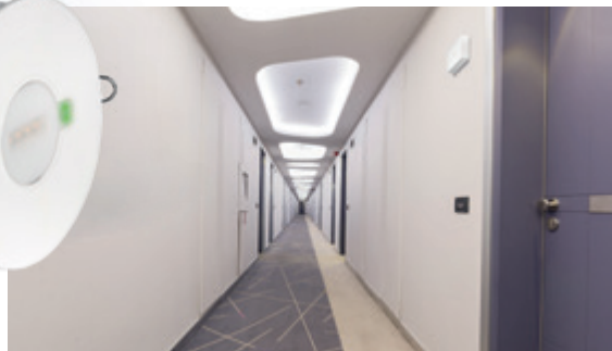
Luces de paso con sensor de movimiento, lámparas piloto Lipso de orientación en la oscuridad y guiado en caso de emergencia.
